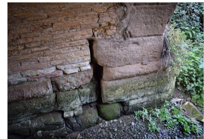
Figura 8: Oquedad en estribo
