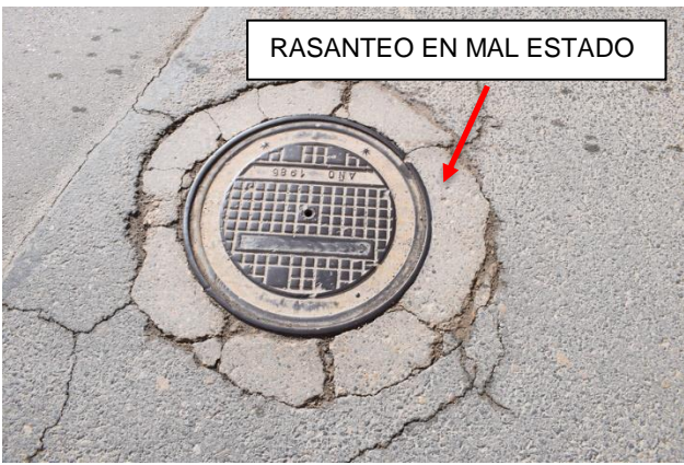
Figura 4: Estado del rasante de arquetas
