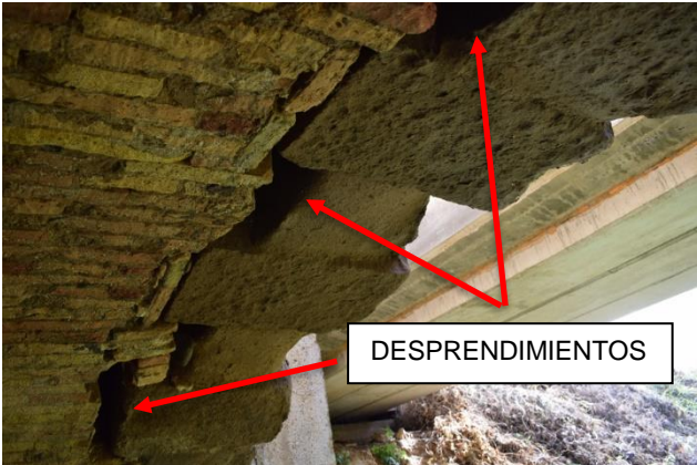
Figura 12: Desprendimientos en las bóvedas
