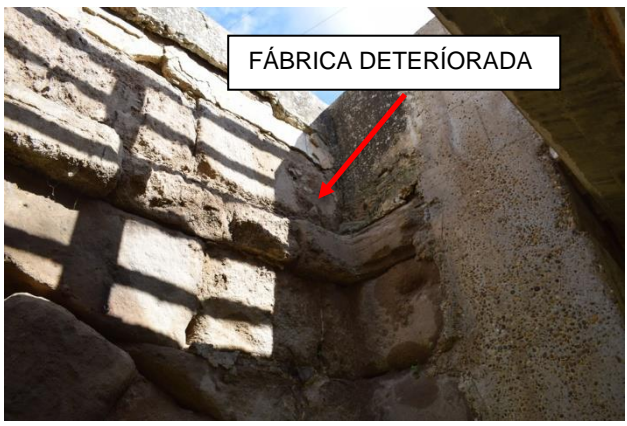
Figura 10: Fábrica deteriorada en alzados
