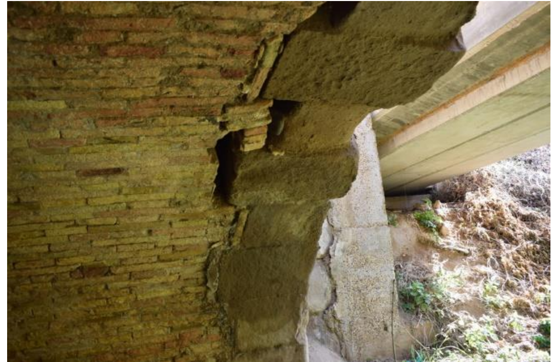
Fotografía 62: Vista oquedad tímpano aguas arriba.
