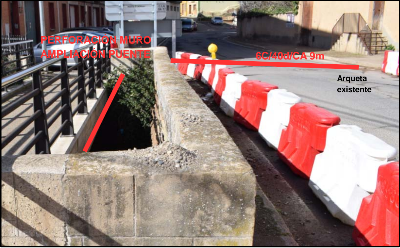
Obra civil a realizar desde la perforación a la arqueta existente de VODAFONE.
