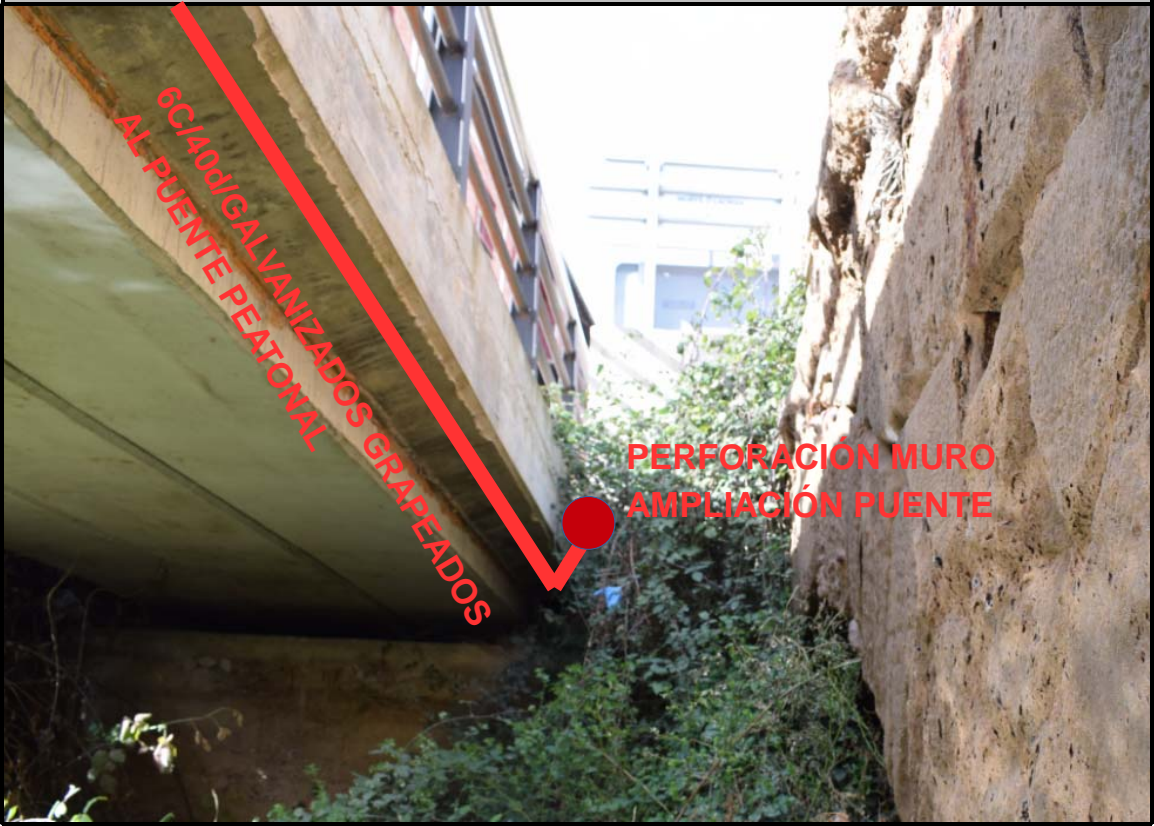
Conductos galvanizados grapeados al puente peatonal.
