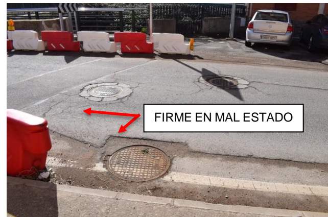
Figura 3: Firme en mal estado
