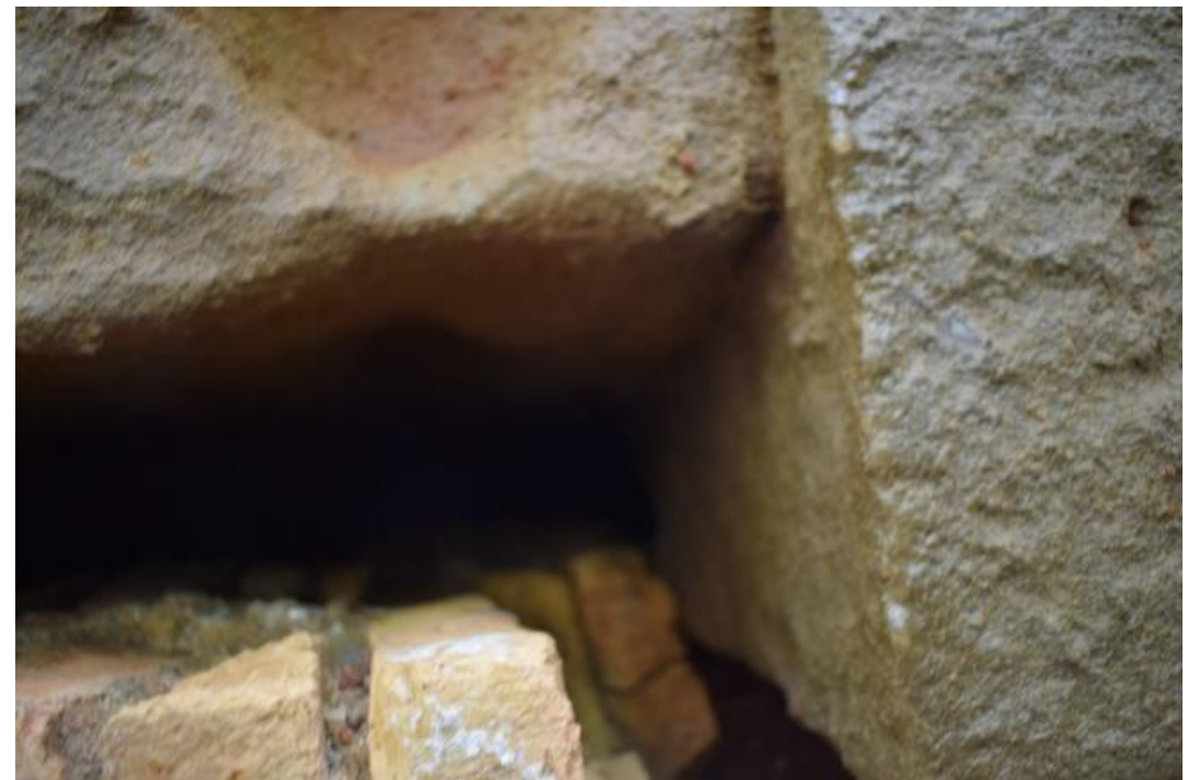
Fotografía 67: Vista oquedad tímpano aguas arriba.
