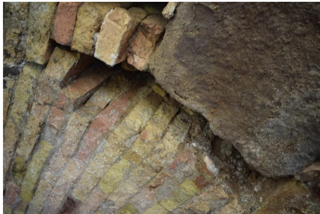
Fotografía 45: Oquedad entre tímpano y arco
