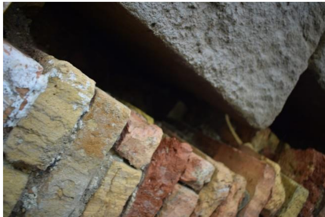
Fotografía 65: Vista oquedad tímpano aguas arriba.
