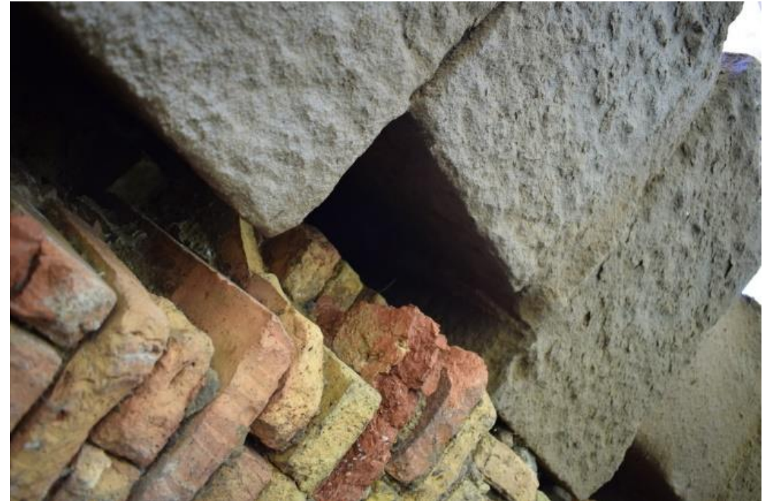
Fotografía 66: Vista oquedad tímpano aguas arriba.
