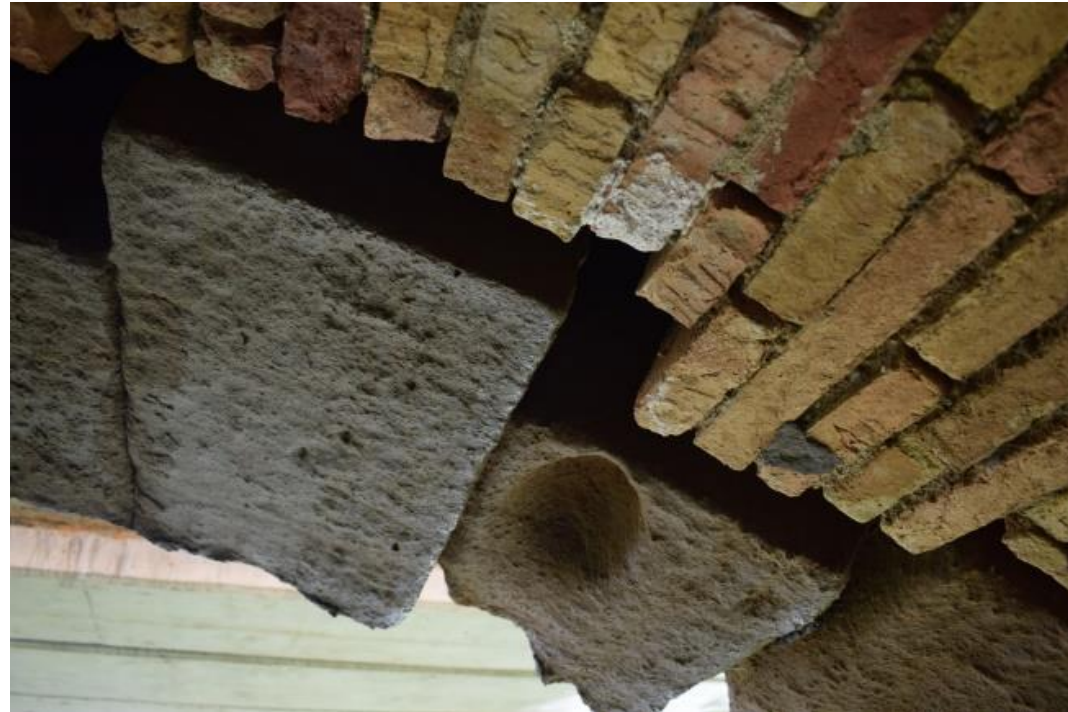
Fotografía 64: Vista oquedad tímpano aguas arriba.
