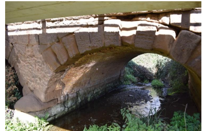
Figura 6: Ausencia de sillares
