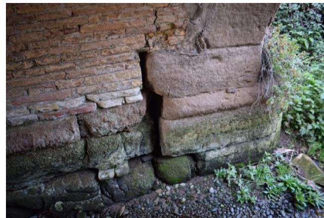
Figura 2: Oquedad en estribo
