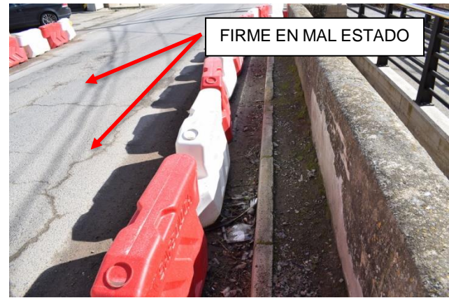
Figura 1: Estado del firme
