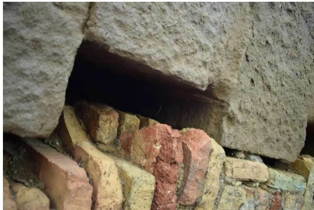
Fotografía 69: Vista oquedad tímpano aguas arriba.
