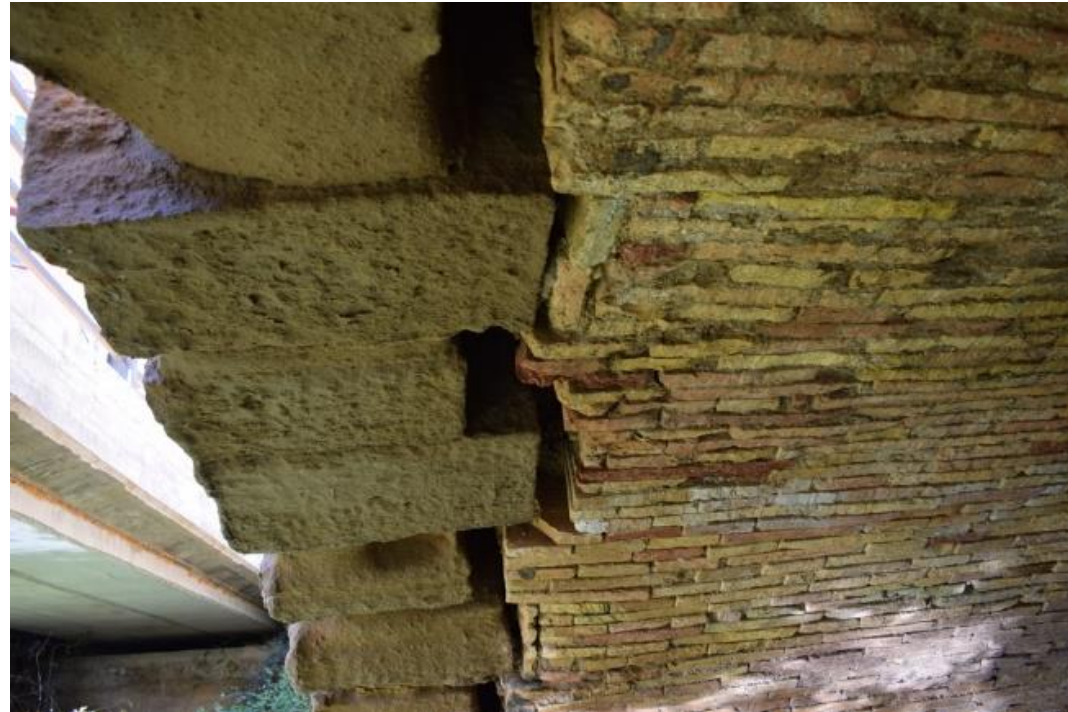
Fotografía 44: Oquedad entre tímpano y arco
