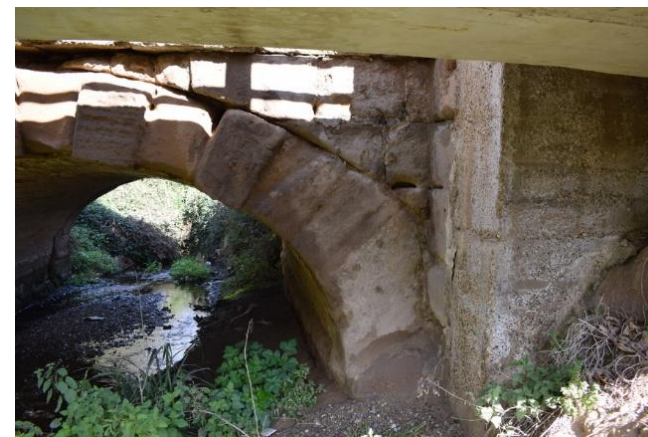
Figura 7: Estado de los sillares de la bóveda
