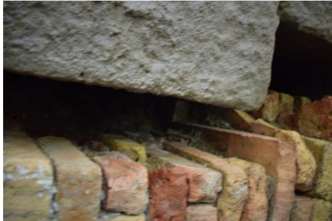
Fotografía 68: Vista oquedad tímpano aguas arriba.
