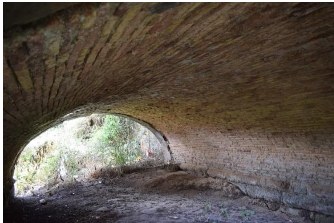
Fotografía 89: Arco de ladrillo del segundo arco
