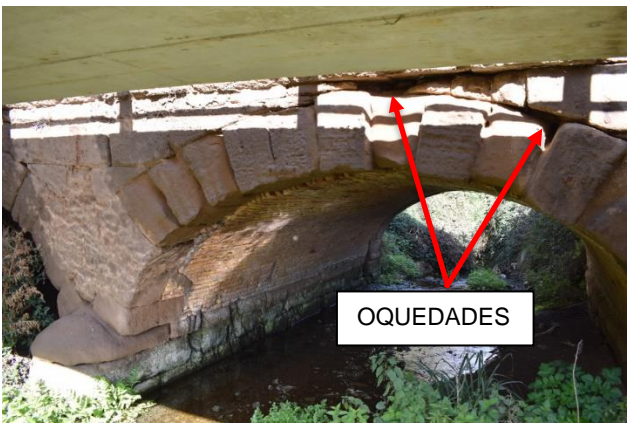
Figura 7: Oquedades en alzados
