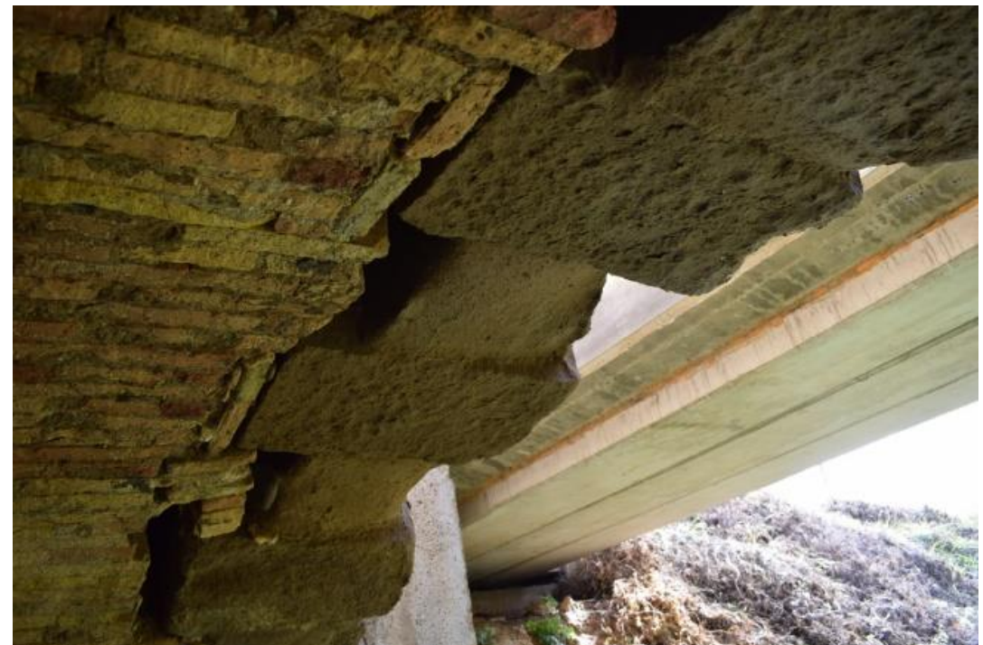
Fotografía 63: Vista oquedad tímpano aguas arriba.
