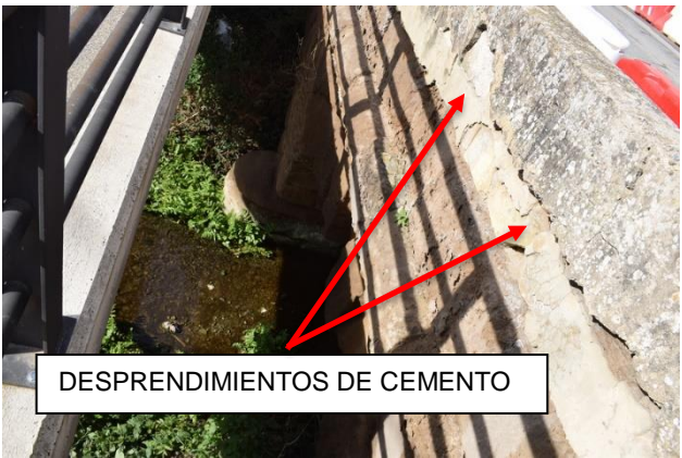
Figura 5: Desprendimientos en alzados
