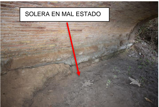
Figura 15: Solera en mal estado
