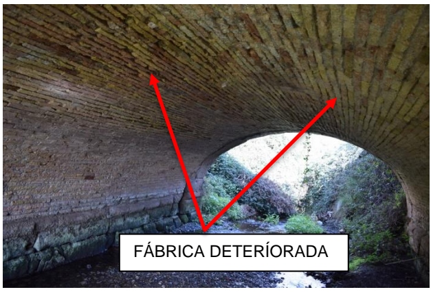
Figura 8: Fábrica deteriorada en bóvedas
